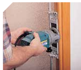
Scharnieren infrezen met de mal CPN66.
