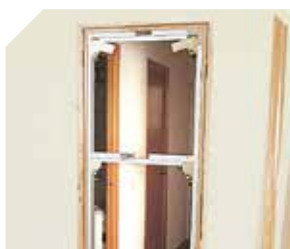
Het plaatsen van de mal.
