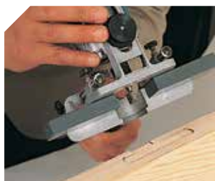
Scharnieren plaatsen met de ZB93 mal
