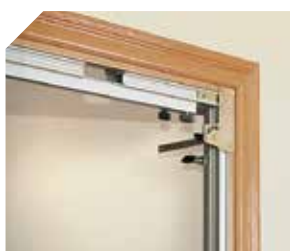
Plaatsen van de deurlijsten met de geleverde stops.
