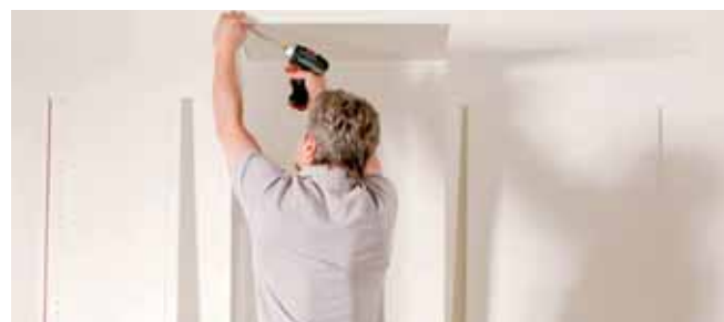
Voorste hoek vastschroeven met de accuschroevendraaier. Zo kan de montage probleemloos door één persoon worden uitgevoerd.
