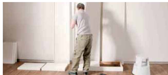
Zijkant van meubel op de sokkel plaatsen. Door de uitstekende schroef staat het element meteen in de juiste stand.
